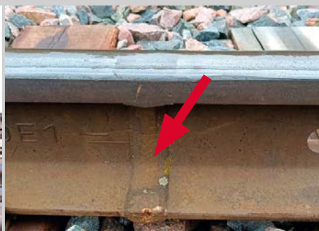
Pilt 80 Pragu rööpakaela termiitkeevislukus
