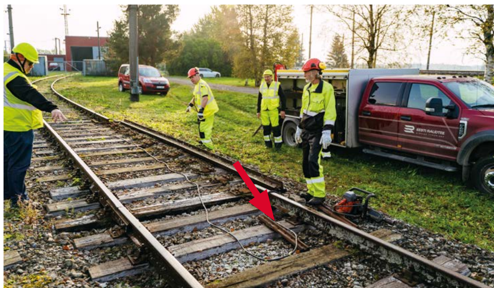
Pilt 37 Ühenduskaabel rööbasahela terviklikkuse tagamiseks
