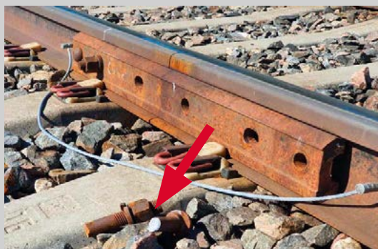
Pilt 77 Suur rööpaluku pilu või lukupoltide murd
