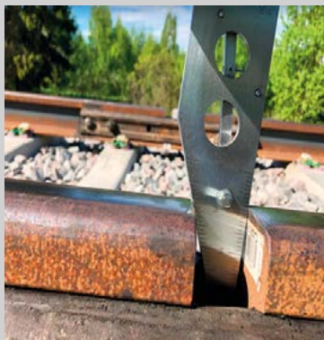
Pilt 76 Rööpaluku sidelapi murd või suur rööpaluku pilu üle 35 mm
