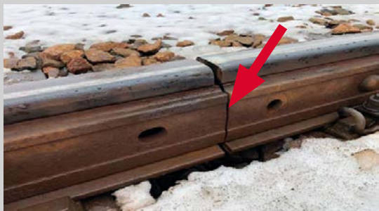
Pilt 76 Rööpaluku sidelapi murd või suur rööpaluku pilu üle 35 mm
