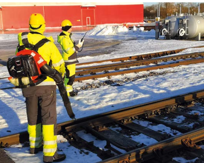
Pilt 73 Lumetörjetööd õhuluuaga kahekesi või käsiluuga üksi
