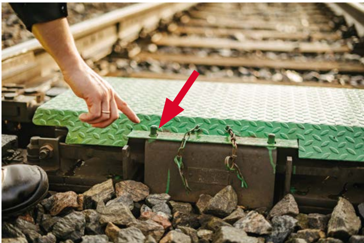
Pilt 82 Fiksaatorsplindid ripuvad ja kaitsekate ei ole lukustatud
